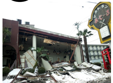
▲壁が倒れ崩れたレストラン(3月11日) 「3.11」市民が撮った震災記録Webより
